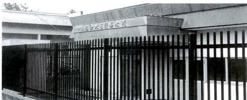
追分地区浄水場
