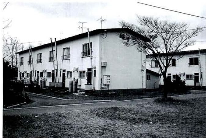
耐震診断（塩口北野市営住宅）
