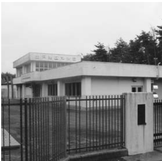
出戸地区浄水場
