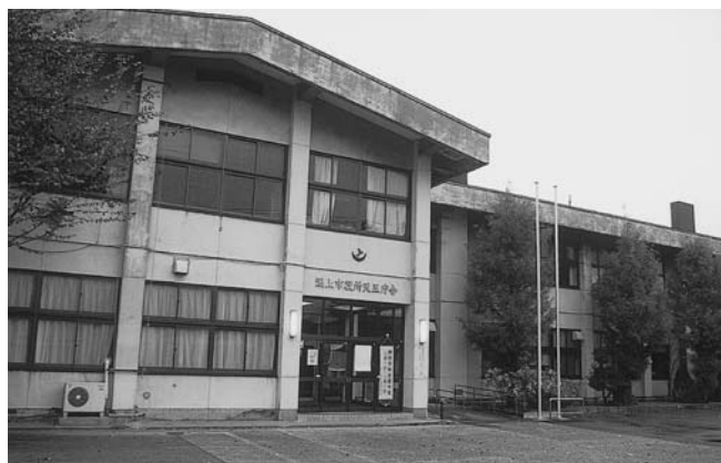
築後44年の老朽化した天王庁舎
