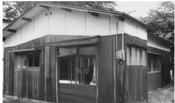
解体予定の牛坂分館
