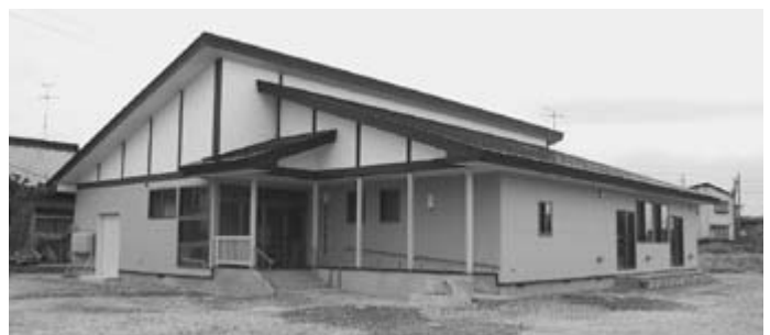
天洋跡地に建設された上町自治会館
