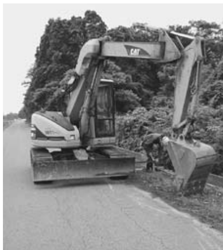
市内工事現場
