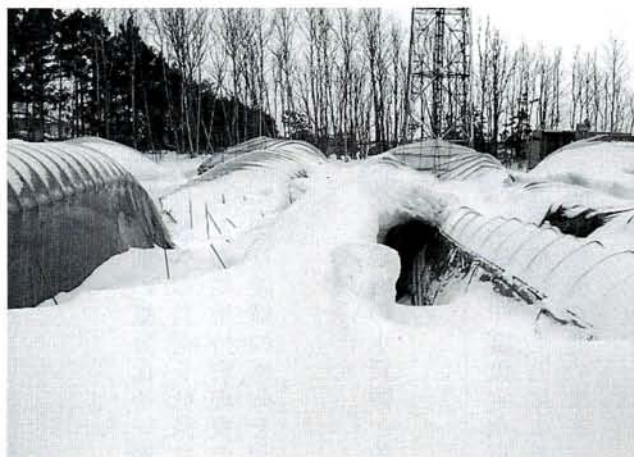
豪雪の被害を受けたハウス
