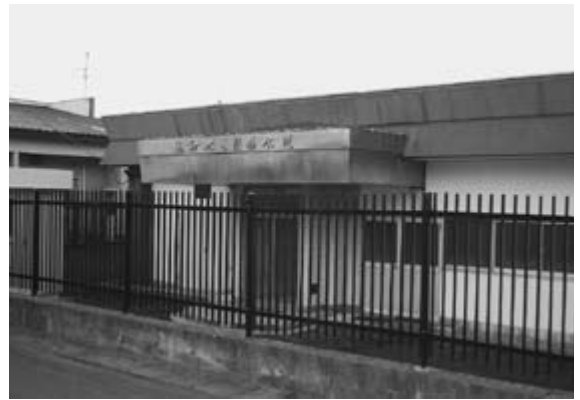
追分地区浄水場
