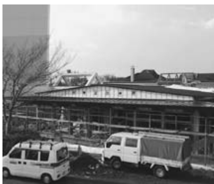
建設中の産直センター（仮称）
