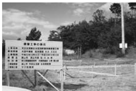
消防器具庫を建設（下出戸農村公園隣接地）
