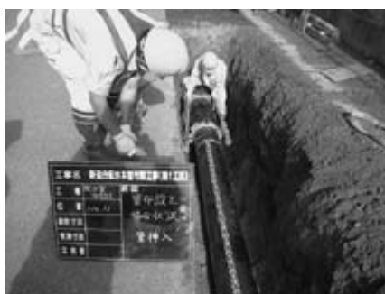
新追分配水本管Φ300mm布設(細谷長根地区)
