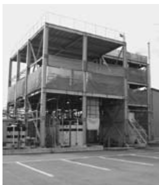
バイオエタノール製造実証プラント
