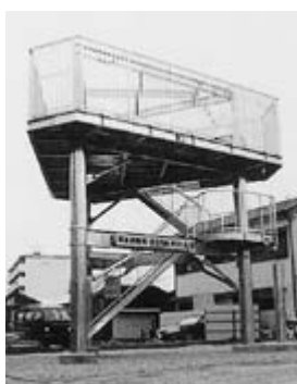
津波避難タワー（三重県）
