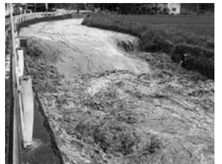
大雨による被害（H22年）
