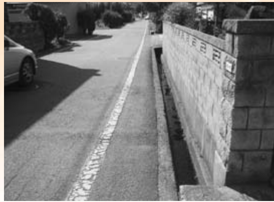
西高入口～ポリテクセンター間の市道
