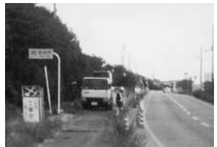
下水道工事完成現場 (秋田市)
