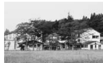
解体される旧豊川小学校
