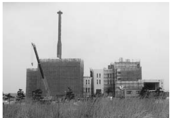
工事中のクリーンセンター
