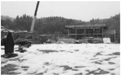
多目的交流施設建設現場
