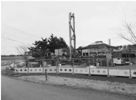
くらら温泉井掘削工事
