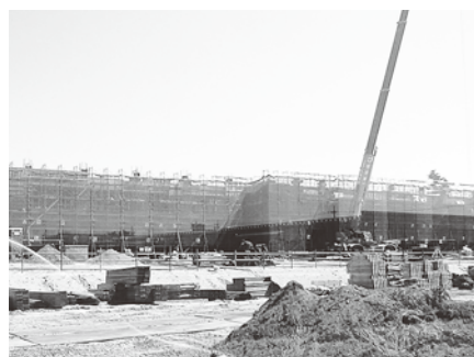
建設が進む新庁舎
