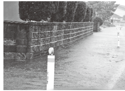
降雨時の冠水現場
