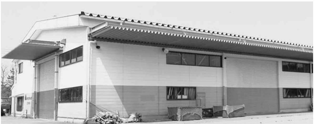
改修予定の貸工場
