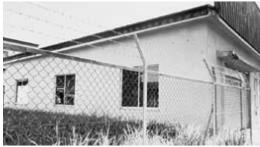
町後ポンプ場
