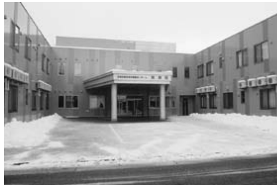
建設中の老人福祉施設
