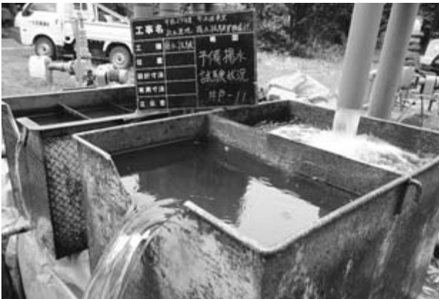
新水源地の揚水試験
