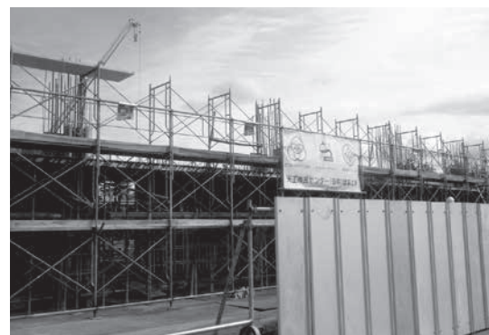
建設中の天王市民センター(仮称)
