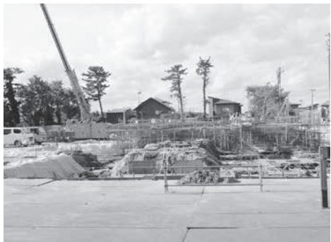
建設中の天王こども園（仮称）
