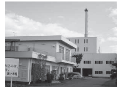
潟上市クリーンセンター (ゴミ焼却施設)
