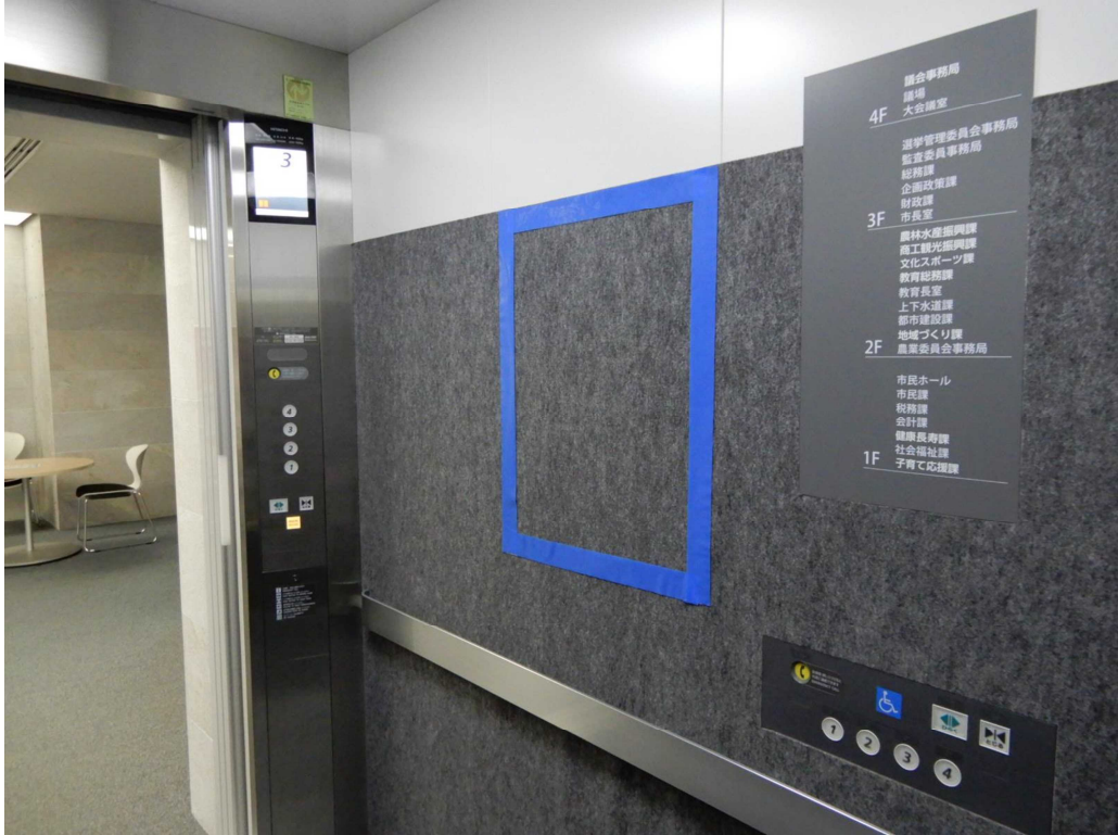
2号機北面 (B2版縦)
