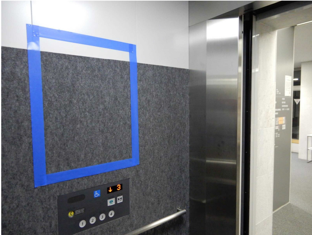
1号機南面 (B2版縦)
