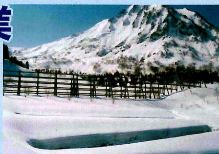
まぜぐち 新潟県糸魚川市大字柵口 減勢工
