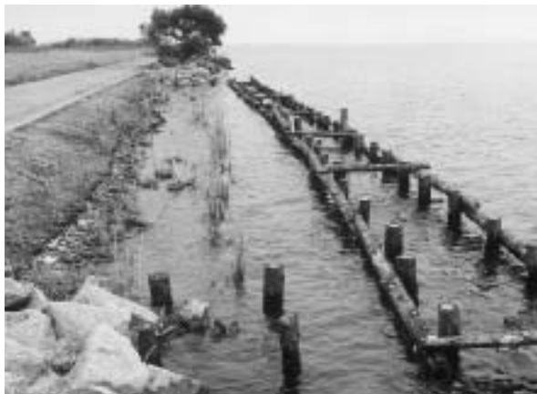
八郎湖天王東排水機場付近に設置された消波堤と浮葉植物
