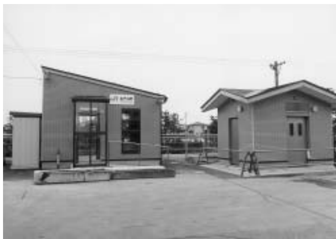
真新しくなった出戸浜駅舎(左)と公衆トイレ(右)
