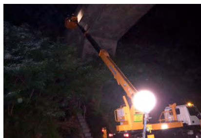
橋梁の点検作業
