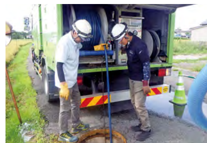
下水道管路の点検・調査
