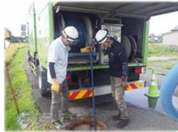
下水道管路の点検・調査
