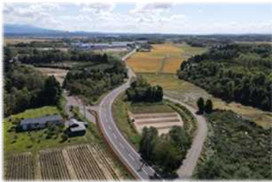
道路改良が完了した 市道武利子沢白洲野樹園地1号線
