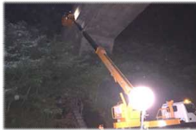
橋梁の点検作業
