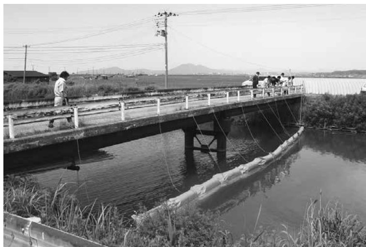
シルトフェンスの設置（馬踏川 河口部）
