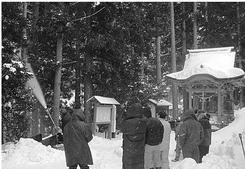
飯田川神明社への防火設備(放水銃)整備 (飯田川飯塚)
