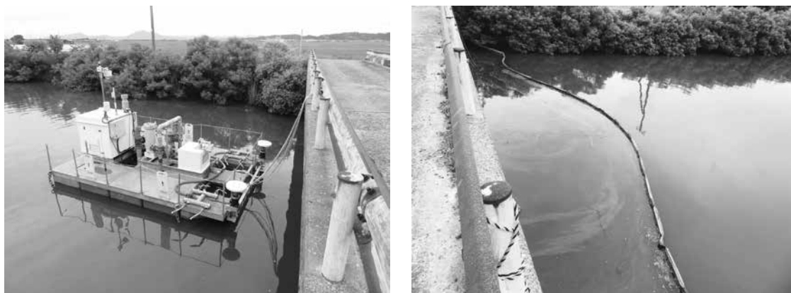
アオコ抑制装置（左）と河川遡上防止フェンス（右）：馬踏川（昭和大久保）
