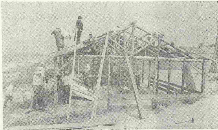
父兄の奉仕で建築中の「出戸小浜の家」
