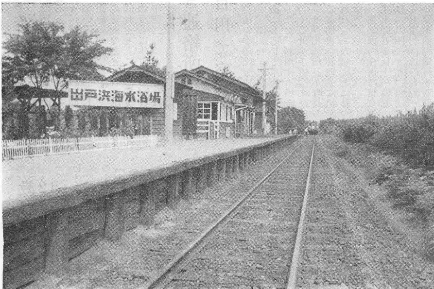
十月までに列車の行き違い設備ができる出戸浜駅
