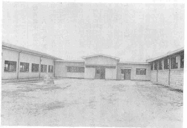
▲完成した新工場(左側)と廊下で通した火災に合った工場(右側)
