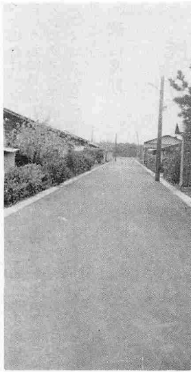
▲舗装工事が完成した二田新町南団地通り
