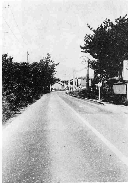
▲ 最初の下水道工事が着工される県道出戸小学校前
