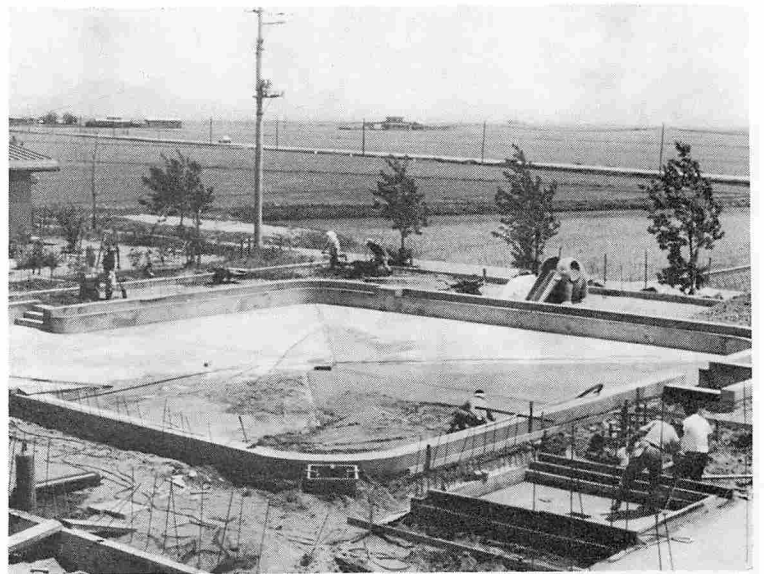
△ 湖岸地区（湖岸保育園に隣接）に、建設中の幼児プール
