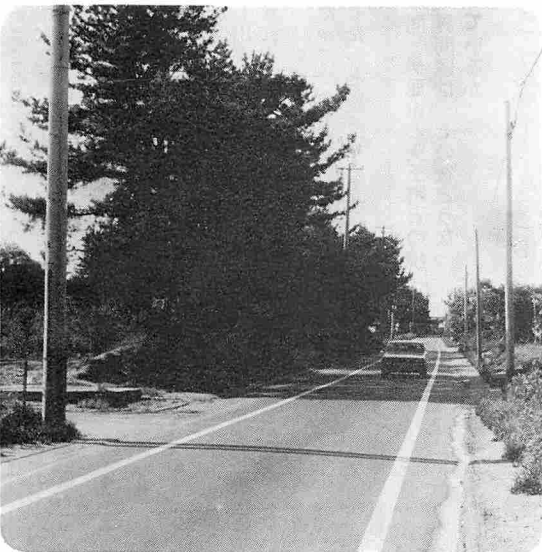
△住宅開発等で雨水処理に困っている町道、二田追分線
