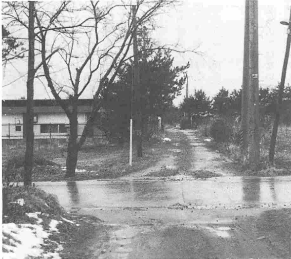
△ 町道に認定された追分地区児童館前の道路
