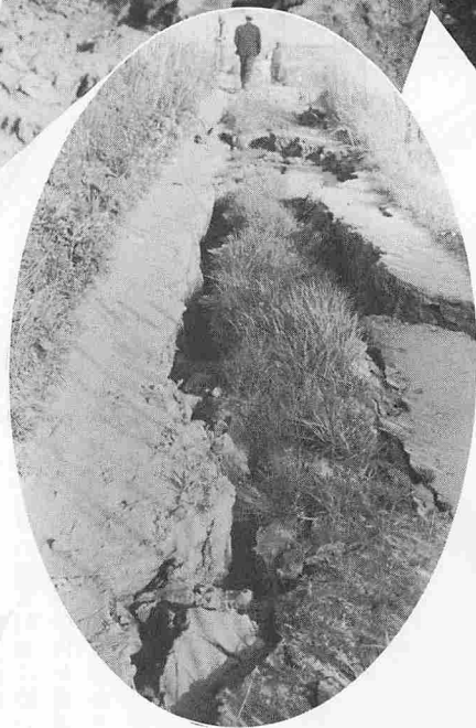
△ 道路全域にわたって陥没した 天王から江川にかけての堤防道路
